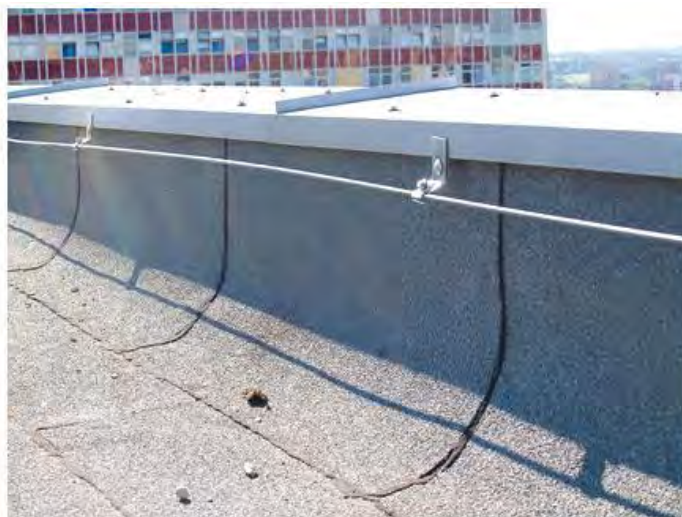
Sposób wykończenia ścianek attyki
