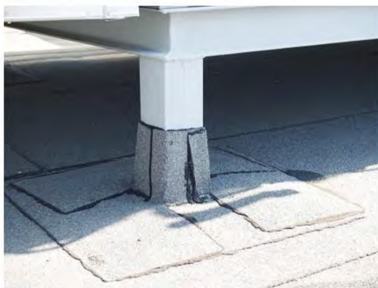
Sposób obrobienia elementu przechodzącego przez papę
